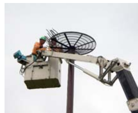
地上 13mでの作業
