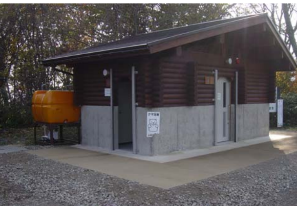
リ・アース工法で周囲を舗装したバイオトイレ(氷ノ山大段ヶ平)
